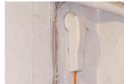
In der Regel befindet sich der Wanddurchbruch im Keller oder Erdgeschoss Ihrer Immobilie. Das Glasfaserkabel wird in das Leerrohr eingezogen.
