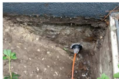
Dann wird das Leerrohr durch die Wand ins Haus eingeführt und versiegelt.
